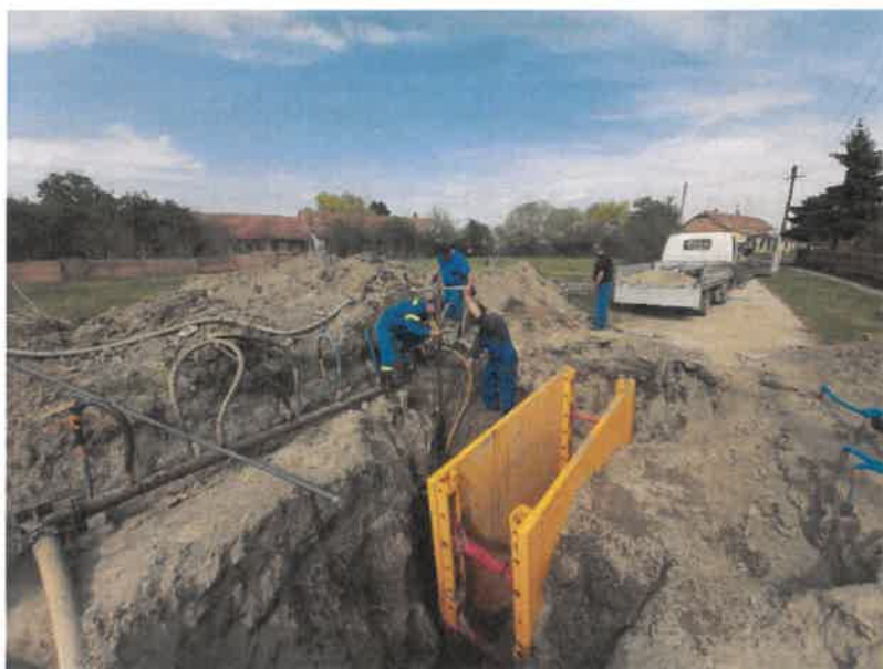
Dúckeret és vákuum kutak telepítése
