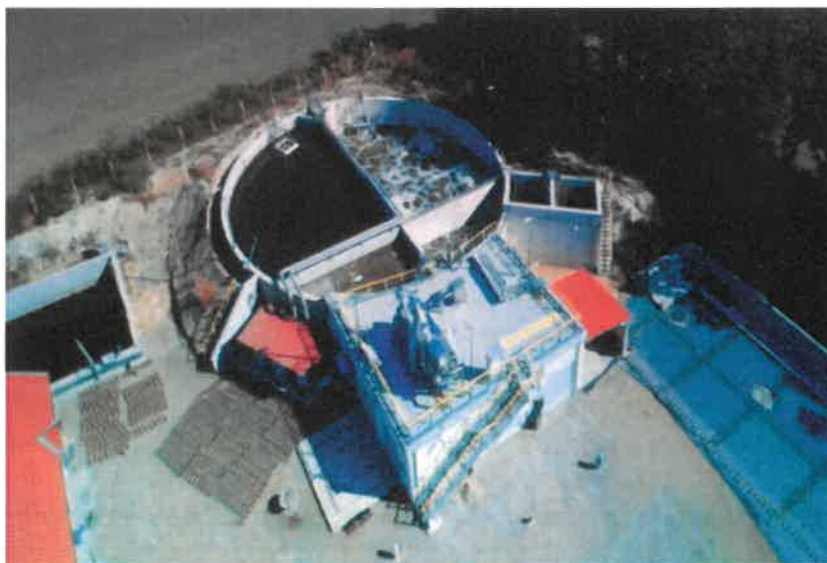
Hartai új szennyvíztisztító telep építése
