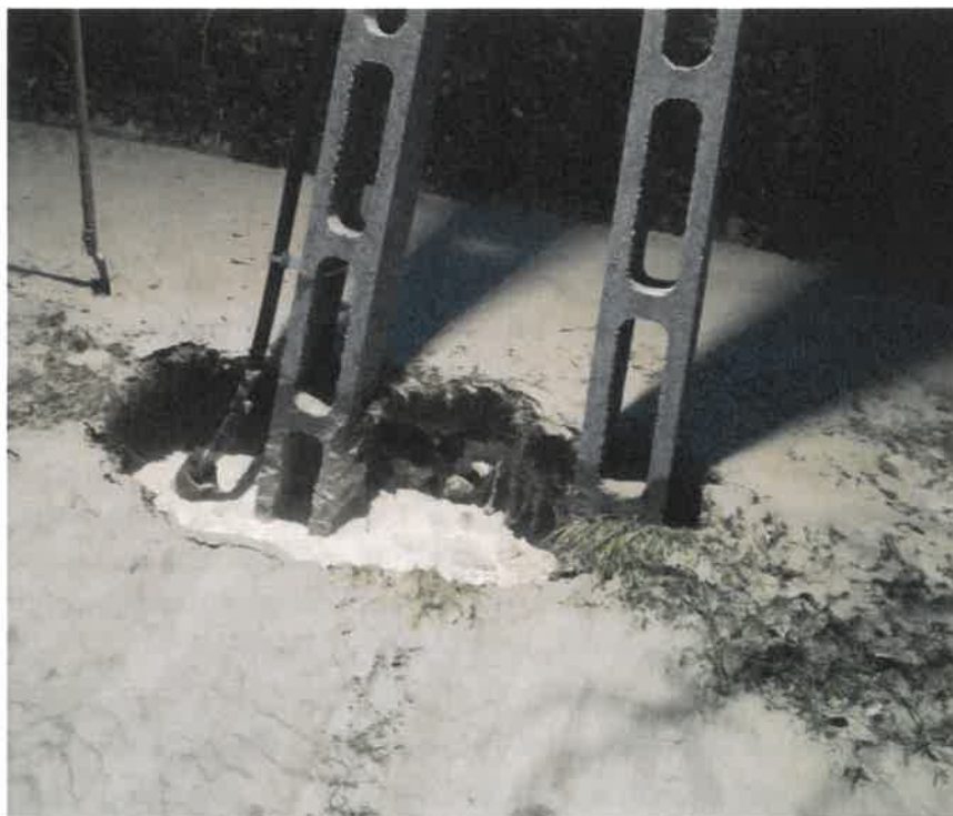
Villanyoszlop tövében lévő csőtörés
