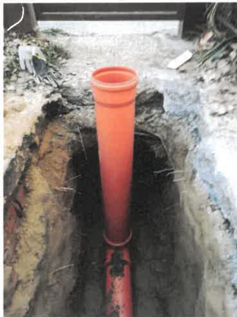
Házi szennyvíz csatorna csatlakozás
