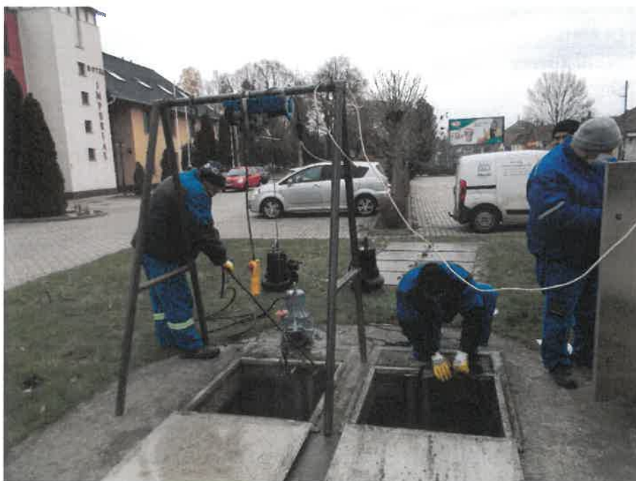
Régi szivattyúk kiépítése átemelő műtárgyból, új szivattyúk telepítése (Kiskőrös)
