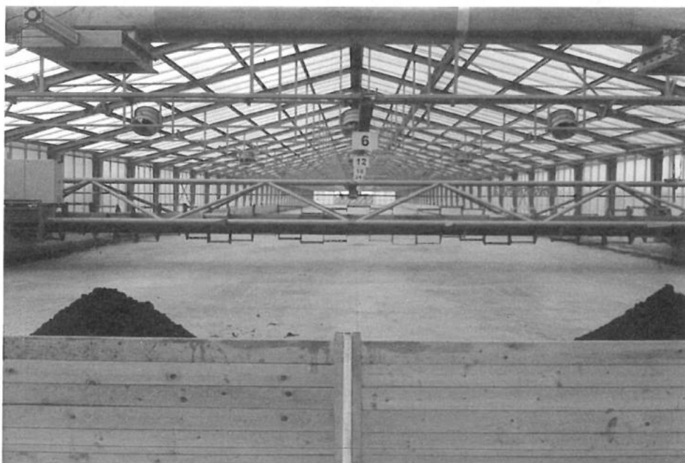
Kiskunhalason alkalmazott iszap víztelenítés
